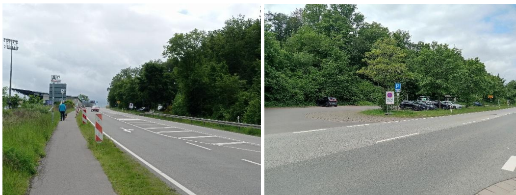
Abbildung 5: Fehlende Bushaldebuchten und der Parkplatz südlich der L 112
