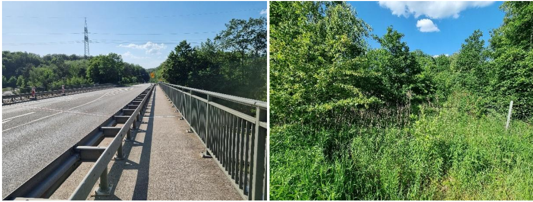
Abbildung 6: Gehweg über die Autobahnbrücke und derzeitiger Bewuchs im Bereich des zukünftigen Gehwegs
