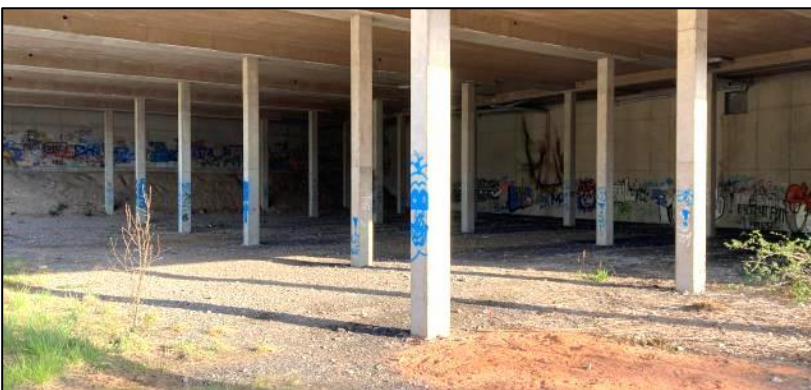
Abb. 3: Luftgeschoss unter Edeka-Markt
